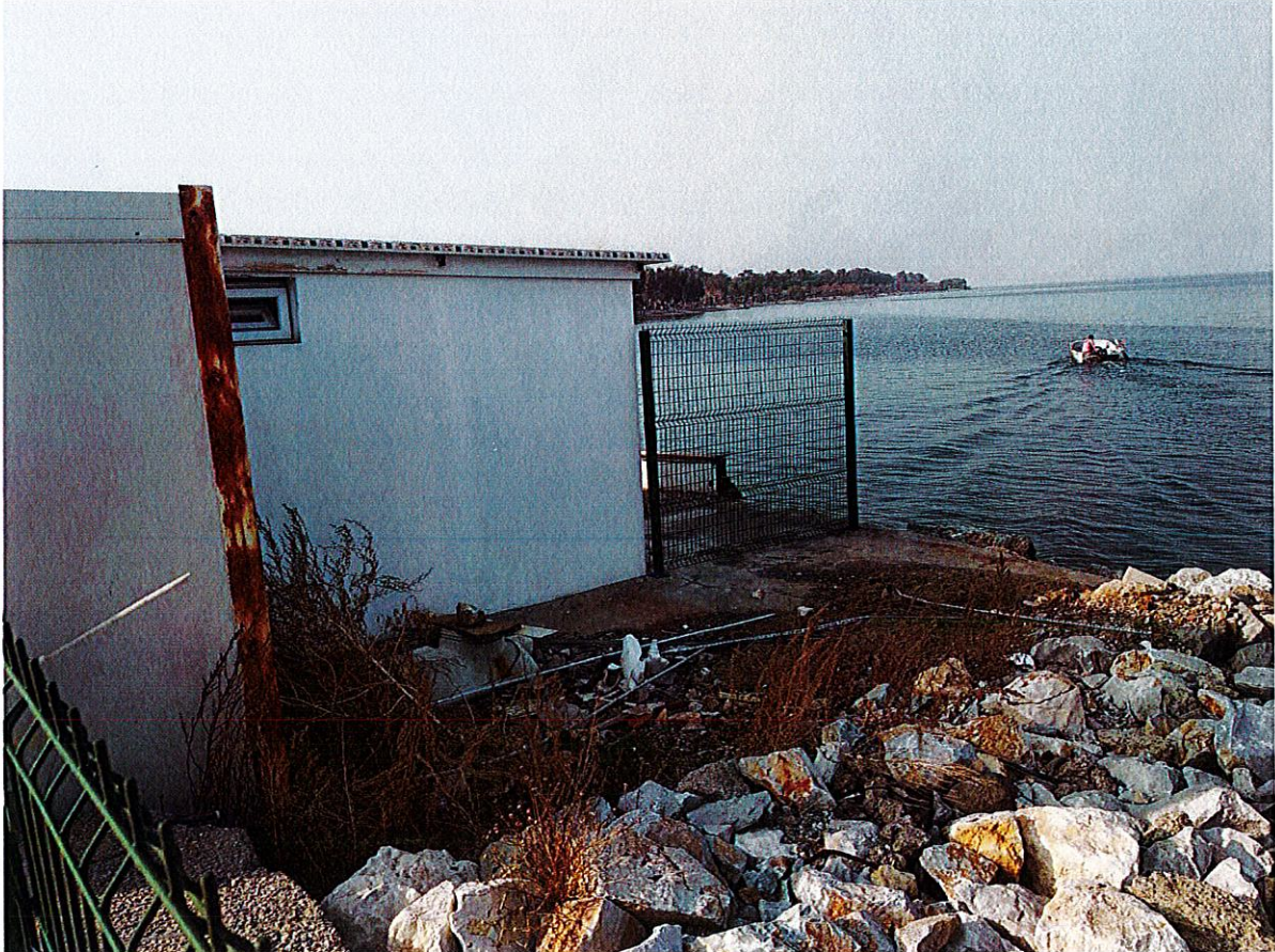
Resim 3.1. Erkek, Bayan ve Engelli WC-Duş yapılacak yerin genel görünümü
